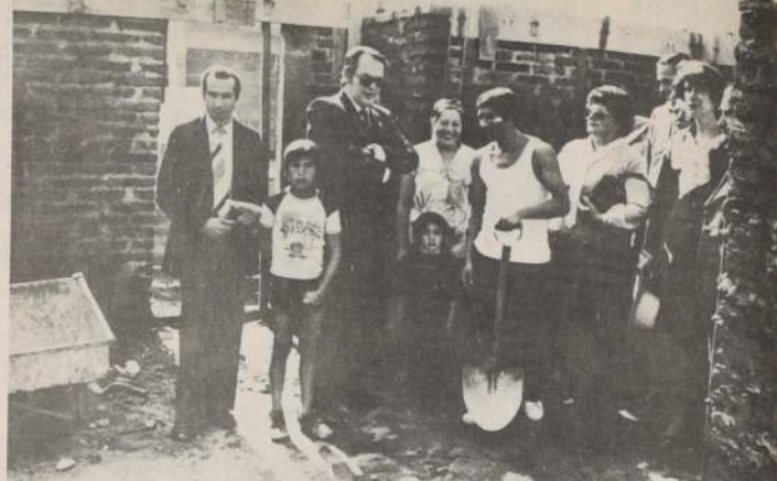
El Alcalde de Puente Alto, Miguel González, felicita al poblador Luis Duarte, quien muestra con orgullo los trabajos de construcción de su vivienda definitiva, junto a la caseta sanitaria que recibió con aporte municipal.
