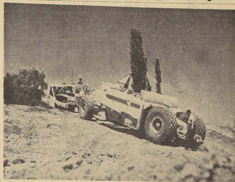
450 HECTAREAS RECIBIRAN MEJOR RIEGO.— En la zona de Bulnes, parte integrante del área del Plan Nuble, se construye un tranque para almacenamiento nocturno de 15 mil metros cúbicos de agua, con los cuales se mejorará el riego de 450 hectáreas agrícolas. Cada cinco minutos se remueven 10 metros cúbicos de tierra por este tractor D-7, con su maciza tralla.
