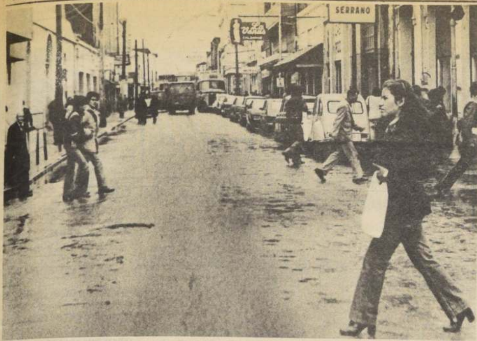
Estado actual de la céntrica calle Bilbao de Talcahuano, entre Colón y San Vicente, que el alcalde Fernando Carrasco proyecta hermosear con la colaboración del comercio del sector.
