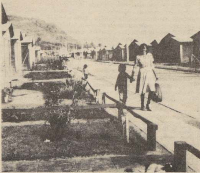
Un aspecto de las viviendas sociales "Paso Los Libertadores", que dieron solución a problemas habitacionales en la comuna.
