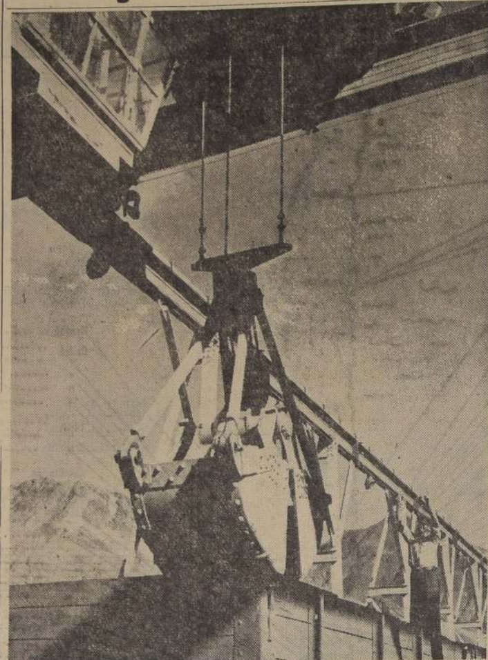
UNA CARGA DE CONCENTRADOS.— Una carga de concentrados, es transportada por una cuchara gigante que, movida por una grúa se mueve desde los vagones de ferrocarril hasta los pozos donde se almacena el mineral.
