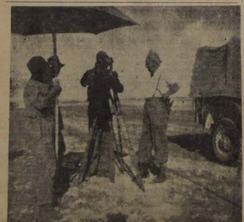
UNA COMISION GEODESICA en la nivelación para una medición de base, en el norte del país.
