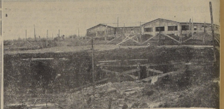
LA IANSA INICIANDO SUS TRABAJOS.— La Industria Azucarera Nacional, que recién iniciaba las excavaciones para echar las bases de los grandes edificios, tallos bajo cuyo alero surgiría el azúcar nacional.
