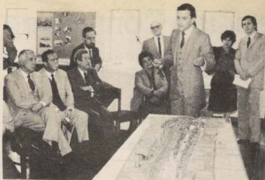
Todos los detalles del nuevo Parque Almagro, proyecto en plena ejecución, conocieron los vecinos del barrio San Diego, directamente vinculados a la nueva obra urbanística.
