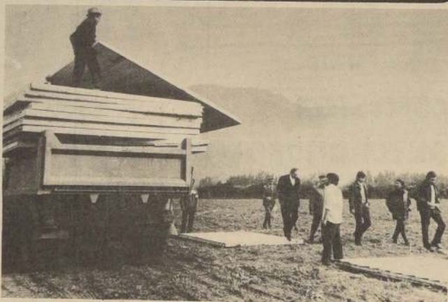
Roberto Cuellar, Subsecretario de Obras Públicas, acompañado por Director de Arquitectura, Carlos Albrecht, y el Intendente de Aconcagua, Nelson Avila, realizaron una visita a los trabajos voluntarios de levantamiento de mediaguas, que funcionarios de OOPP y de la Compañía de Teléfonos realizan en Catemu, San Felipe y Los Andes.
