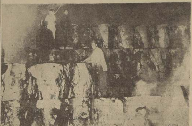
Las bobinas de papel son consumidas por el fuego durante el incendio en las bodegas de la Papelería de Puente Alto. Los bomberos, secundados por el personal, combaten las llamas.
