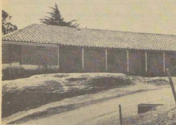
Esta centenaria casa fue construida por Daniel Ortúzar cerca del año 1876. La vivienda es un gran atractivo turístico de la zona.
