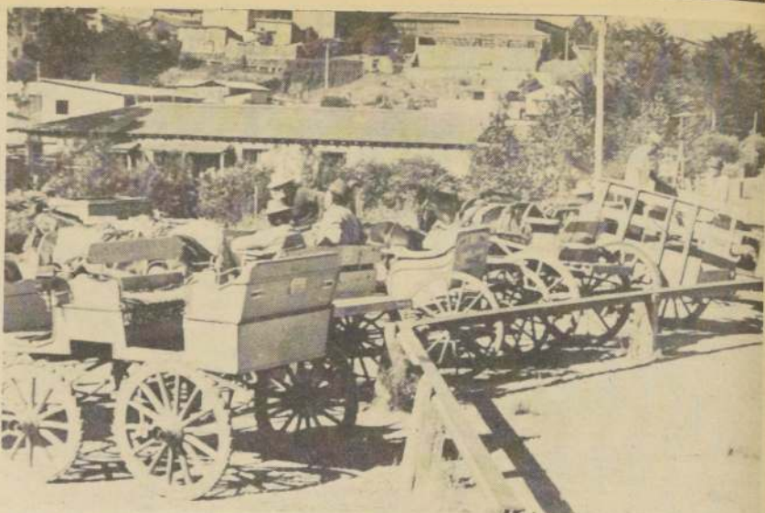
Los "taxis" de este popular balneario de la zona central. Las cabritas, antiguos transportes, siguen prestando la misma utilidad de antaño.
