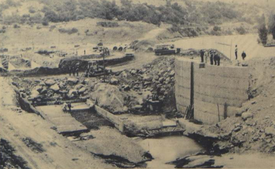
Aspecto parcial de las obras de toma en el río Mapo, primera fase de un trabajo de gran magnitud aludado por la Empresa de Agua Potable, que permitirá, en un plazo prudente, abastecer plenamente a la ciudad de Santiago. Actualmente, las plantas de Las Vizcachas y Las Vizcachitas captan sus aguas del río Mapo mediante una toma en el Canal San Carlos.
