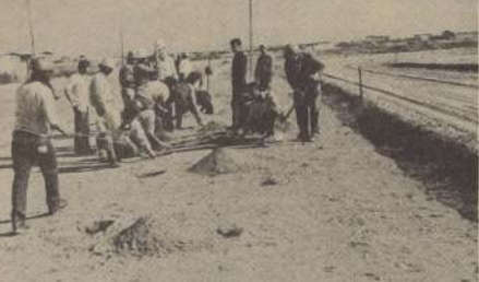
Trabajadores de la Mina, en plena faena productiva en la limpieza de una futura cancha deportiva para el desarrollo cultural y físico de los trabajadores.
