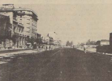
Una amplia vía de acceso, en el sector de la Plaza Buñes, sobre los trabajos del Metropolitano.
