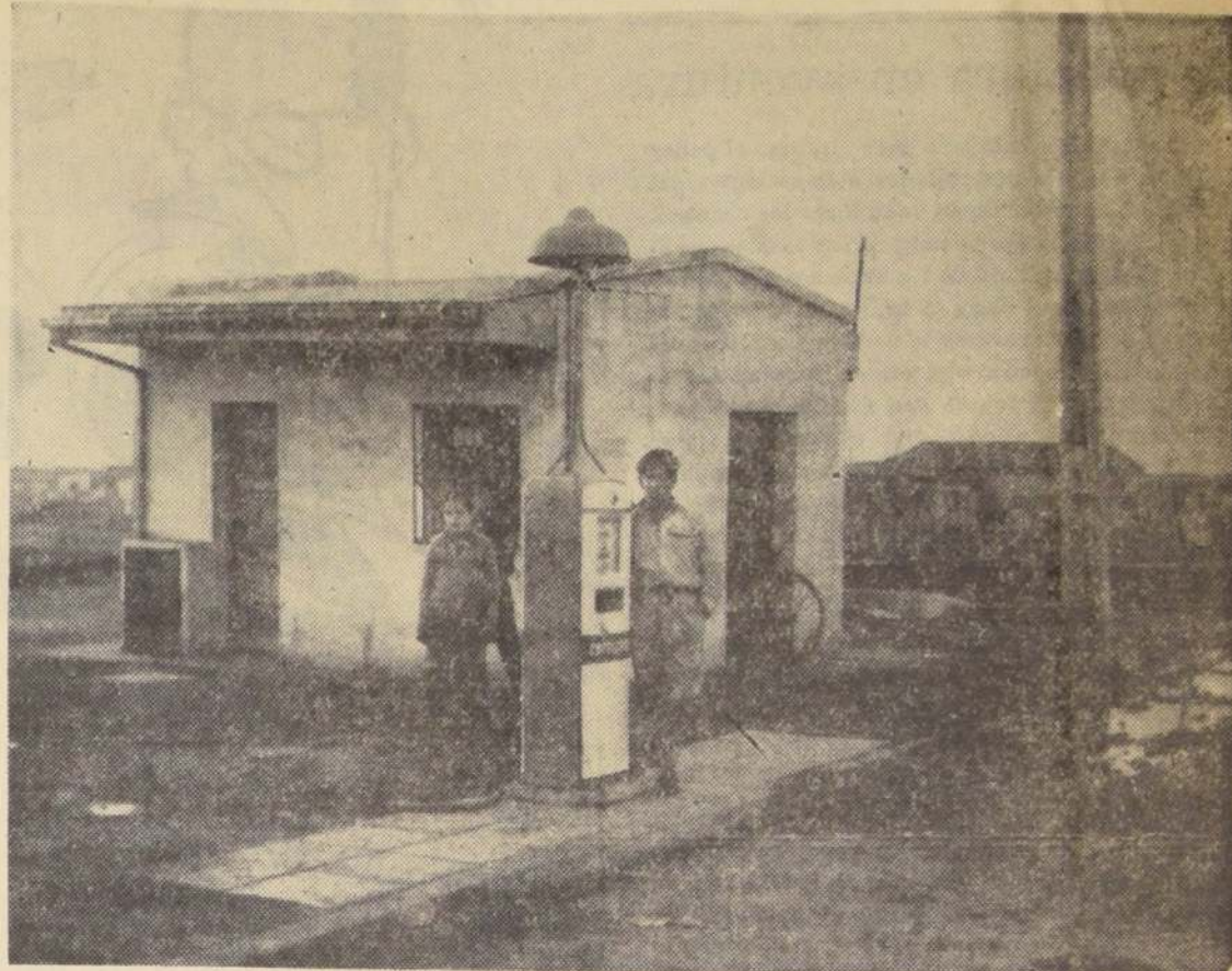
Población Victoria Bomba de gasolina.
