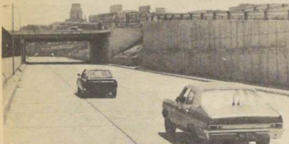
Vecinos de la Carretera Norte-Sur ofrecen financiar la habilitación y mantención de un área verde.
