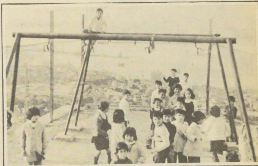
AHORA.— El hoyo que existía en el patio fue rellenado y se colocó una malla de alambre para evitar que los escolares cayeran a la quebrada.
