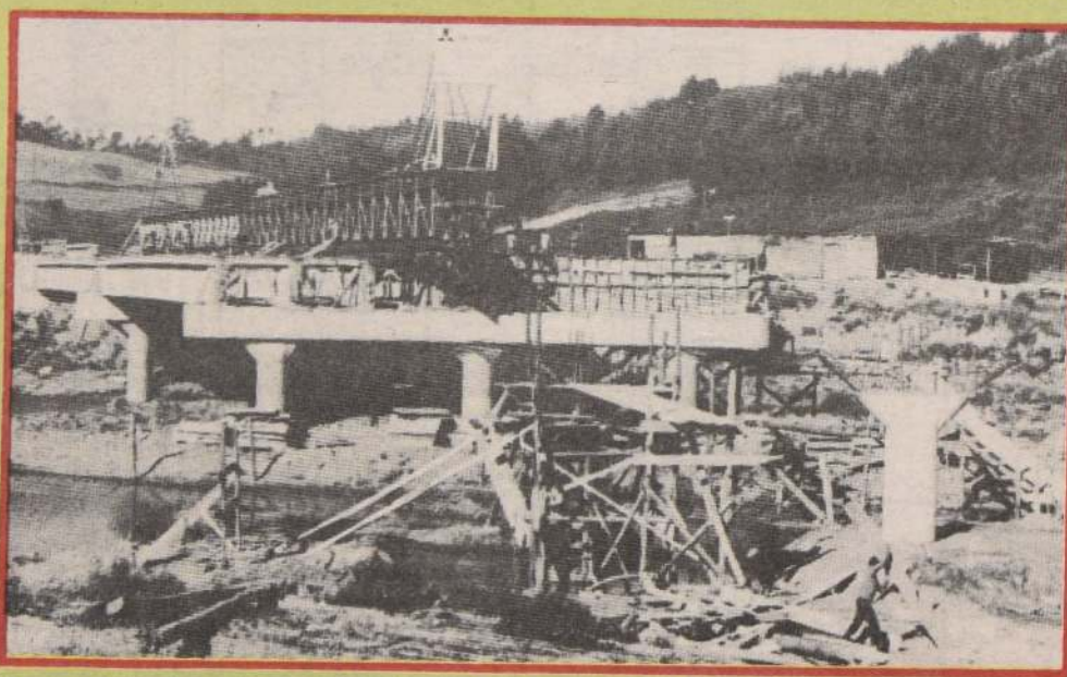
Dos paneles de hormigón de 32 metros cada uno, más la base norte ya han sido terminados y en días de sol, viento y faena incesante se avanza hacia el extremo sur, hacia la avenida Oscar Bonilla.
