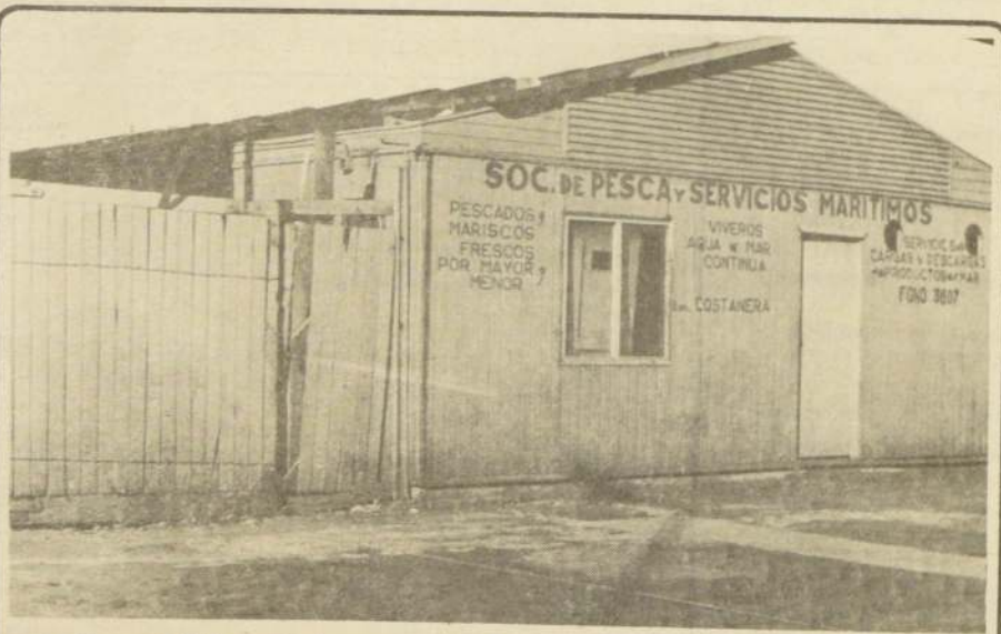
La Pesquera Falken está dismantelando su galpón instalado en la Avenida Costanera, al caducar la concesión
