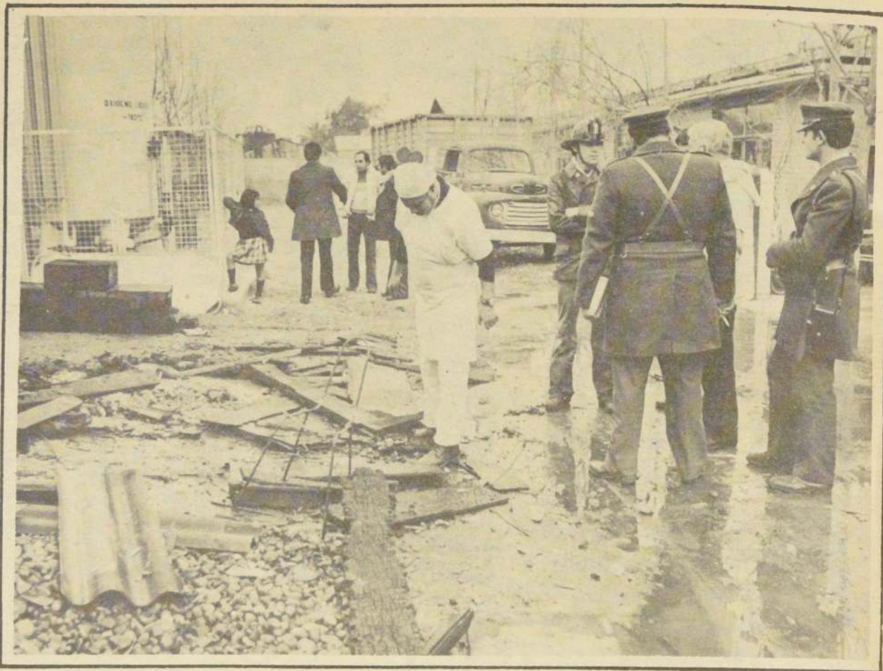
La rápida acción de un funcionario evitó una tragedia de proporciones en el incendio que se registró ayer en el Hospital Barros Luco. En la fotografía, un aspecto del siniestro ya sofocado, por la oportuna intervención de bomberos.
