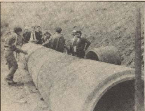
Una labor extraordinaria se está cumpliendo en el sector sur de Valparaíso, donde se construye el camino costero que conectará con la provincia de San Antonio. Enormes quebradas han debido ser rellenadas previamente para colocar las enormes tuberías que permitirán la evacuación de las aguas-lluvias, según se aprecia en la escena.
