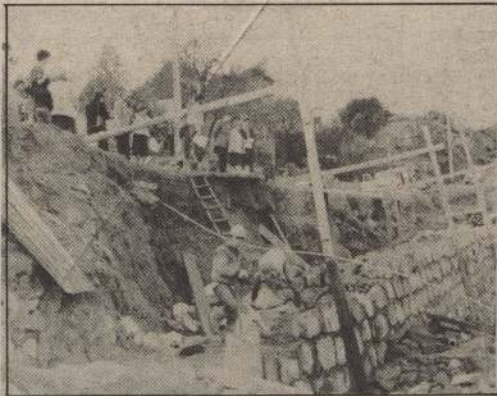
La inversión municipal en obras de infraestructura en los cerros de Valparaíso alcanza crecientes sumas cada año, para consolidar el adelanto en la parte alta de la ciudad. En la fotografía, las obras de construcción de un muro de contención en calle Ibsen, de cerro Delicias, que permitirá recuperar una importante vía de acceso, que se había deteriorado por las lluvias. La inversión en estas faenas supera los 4 millones de pesos.
