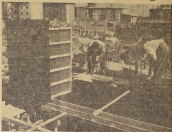
Las planchas Chiloan se emplean con positivas ventajas en moldaje para concreto. El grabado corresponde a la construcción de la "Fábrica Ochagavía de la CORVI."
