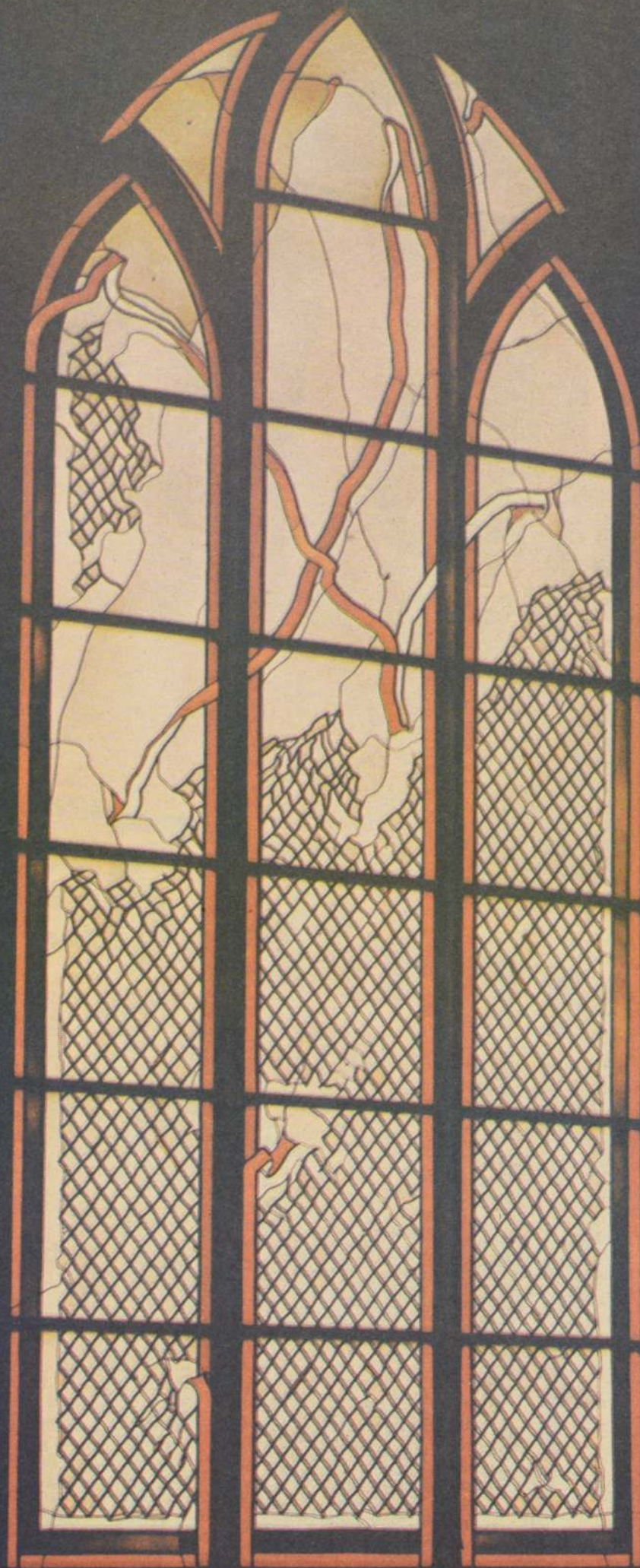
El orden se descompone, muestra huellas de caducidad: ventanal en la nave transversal de St. Laurentius, Niederkalbach, 1980.
