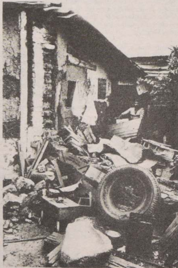
En Pudahuel las casas quedaron destruidas. En esta, por ejemplo, quedan sólo las paredes interiores.
