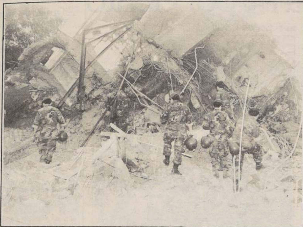
Buzos tácticos de la Armada Nacional proceden a una última minuciosa revisión de los restos del edificio "El Faro" para detectar cualquier problema. El inmueble, de 7 pisos, cayó con extraordinaria precisión sobre la misma área de la base.
