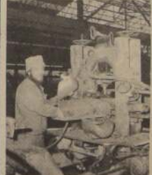
Máquina para armar vigas doble T.
