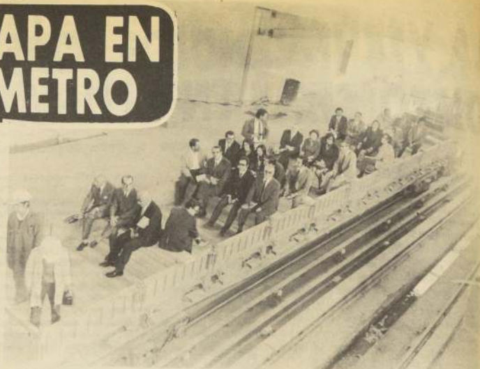
Profesionales de los distintos colegios hacen un recorrido por el primer tramo del túnel de la primera etapa del metro.
