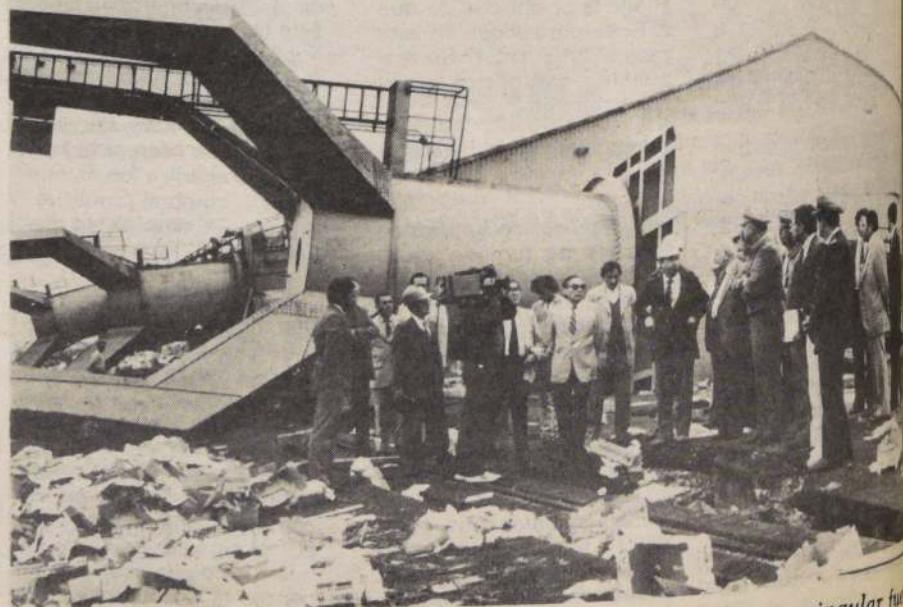
Seis gigantescas grúas destruyó el violento sismo, que se sintió con singular fuerza en el Puerto de San Antonio. La fotografía ahorra comentarios.
