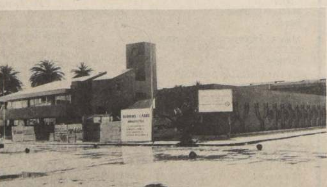
A fin de mes quedará totalmente terminado el edificio del Centro de Rehabilitación Infantil, construido con los aportes de la Tercera "Teleton", en Valparaíso.
