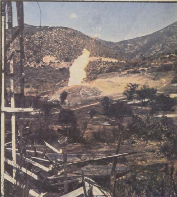
Una gigantesca llamarada, de decenas de metros de altura, continuaba saliendo hasta esta madrugada del gasoducto que estalló a las 0.50 horas de ayer, a la altura del kilómetro 62 de la carretera de Santiago a Valparaíso, a mil 500 metros del túnel Zapata.
