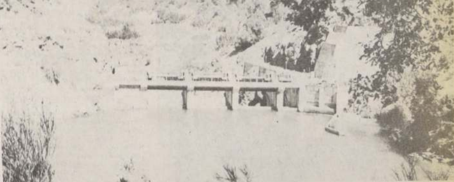
Vista del lago artificial e instalaciones de la central hidroeléctrica de Cipreses, una de las bases del desarrollo de la Región del Maule.
