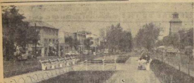
LA AVENIDA MATTÁ, totalmente transformada y convertida en una de las más hermosas arterias del país. En esta avenida se instaló un moderno servicio electrónico de semáforos que sólo lo tienen las grandes
