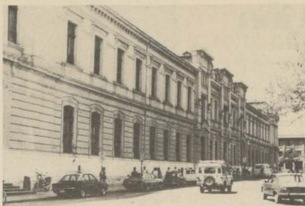
Aspecto general de la Cárcel de Santiago o Centro de Detención Preventiva.
