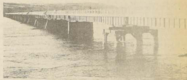
Reestructuraciones en Puente Pudeto, asegurando buen funcionamiento para ocho o nueve años más.
