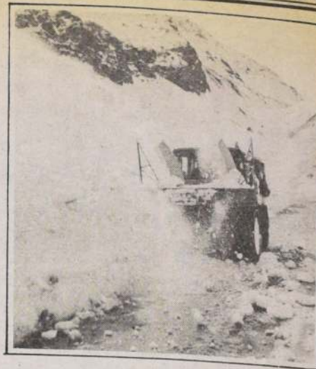
Camiones de vialidad trabajan arduamente para despejar el camino internacional a Mendoza, cuyo tránsito quedó bloqueado durante varios días debido a los temporales de nieve.
