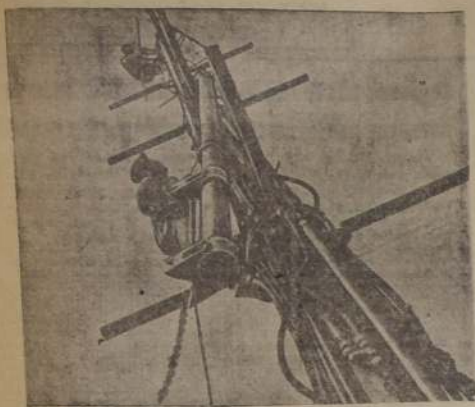
Instalación de un pararrayos especial de la General Electric Company que se eleva a poco más de 18 metros sobre el rascacielos neoyorquino Empire State Building, el cual a su vez mide 381 metros de alto.
