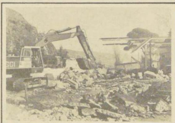
Retroexcavadoras participan activamente en la demolición de las construcciones que conforman la maestranza ferroviaria.
