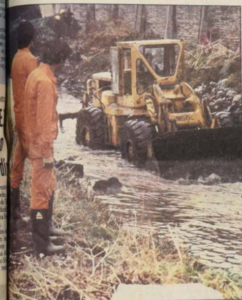
Maquinaria pesada se está removiendo el fondo del Zanjón, a fin de permitir el rápido y más profundo escurrimiento del agua evacuado. Posteriormente se harán defensas ribereñas, cierras y jardines, destinados a proteger a la población de las inundaciones. Mantener limpio el sector.
