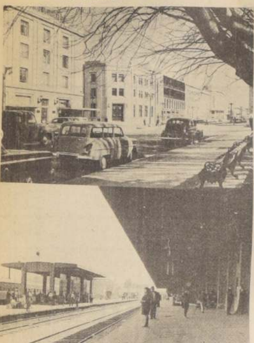
Concepción se supera de toda forma. En el grabado superior, se observa una de las calles céntricas de la ciudad, y abajo, la Estación de los Ferrocarriles del Estado, moderna construcción, que es ejemplo en el país.
