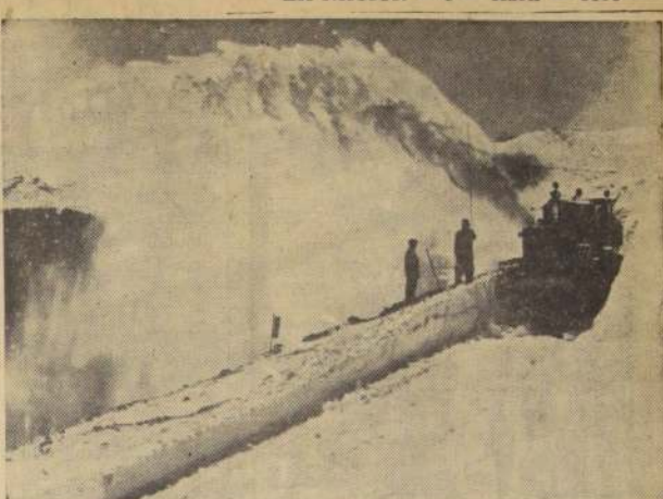
LIMPIADORA DE NIEVE EN RIO BLANCO. La Cerro Corporation, propietaria del mineral de cobre de Río Blanco, ha importado esta máquina limpiadora de nieve, para mantener abiertos los caminos hacia el yacimiento, aún en pleno invierno. La máquina, un arado rotatorio para nieve, puede remover hasta 2.500 toneladas de nieve por hora. Los chorros de nieve que lanza hacia los costados del camino, a través de tubos de escape, alcanzan a una distancia de hasta 25 y 30 metros. El resultado es que va dejando tras de sí un camino con apenas 1 centímetro y medio de nieve, por el cual pueden transitar sin dificultades automóviles y camiones. La traida de este moderno equipo barreador de nieve, que se encuentra operando en el mineral, permitirá avanzar rápidamente en los trabajos de habilitación y explotación del mineral, y en ese sentido ya se ha iniciado la construcción de los túneles de acceso para extraer el mineral que conducido en correas transportadoras será llevado a la planta de concentrados. Aun cuando la faena minera podrá desarrollarse bajo tierra, persiste la necesidad de mantener abiertos los caminos y esa es la misión que cumplirá esta "rotary snow plow".
