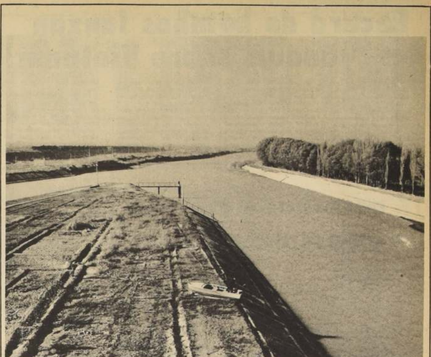
El canal meridional de la Estepa del Hambre, de 126 kilómetros, parte del río Sir Daria. En su nacimiento tiene un caudal de 300 metros cúbicos por segundo. Con sus aguas se riegan 300.000 hectáreas de tierra en las repúblicas de Uzbekia y Tadzikiá. Foto APN A 69 30460.
