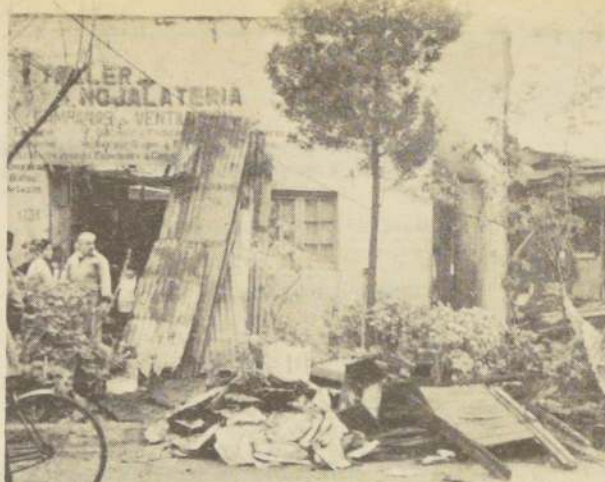
Este es el estado en que quedaron los inmuebles de calle Gálvez 1729 y 1731, afectados por un incendio ayer en la madrugada. A causa del fuego, resultaron damnificadas seis familias, las que perdieron sus enseres. Las viviendas eran de propiedad de la firma Elgueta-Fuenzalida y del particular Daniel Rodríguez.
