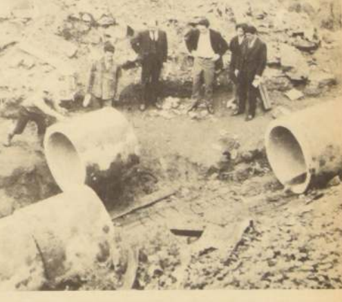
municipal señor José Dennet, inspecciona los trabajos de abovedamiento de la quebrada en Miramar Bajo, que soluciona un problema de saneamiento en ese sector.
