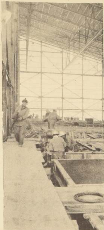
ARMAZON METALICA DEL NUEVO CONCENTRADOR DE COLON
