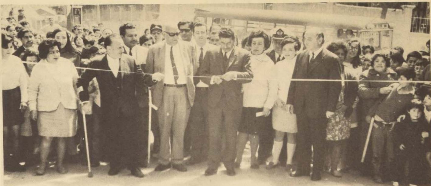
El alcalde de Valparaíso, señor Juan Rodríguez López, inaugura los trabajos de pavimentación en Rocuant, que permitieron la ampliación de los servicios de locomoción colectiva hasta sectores
