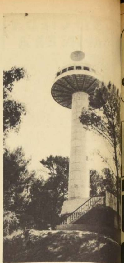
TERMINAL de la Red de Microondas en el Cerro Caracal de Concepción
