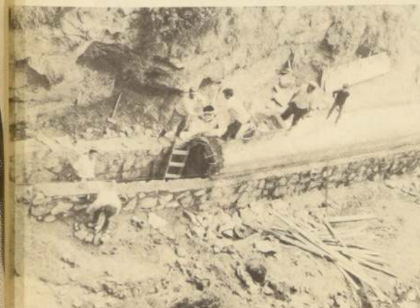
INTENSA LABOR COMUNAL. En el grabado de la izquierda se ven los trabajos de abovedamiento de la Quebrada Villagrán en el Cerro Yungay, que permitirán posteriormente el relleno de ella para la construcción de una importante vía de acceso a
