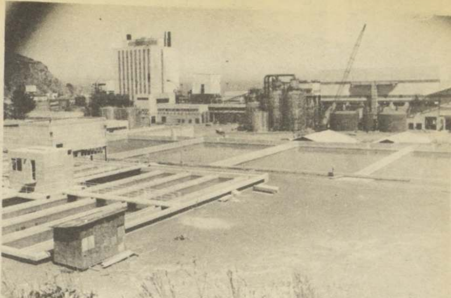
Estanques de flotación, tratamiento y almacenamiento de la Planta de Agua de CELCO, que abastecerá con 60 millones de litros diarios las necesidades de la Planta Industrial.
