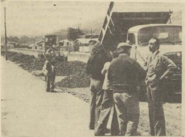
Intensa actividad se observa en diferentes localidades de la provincia de Arauco, en las que se realizan trabajos para el arreglo de calles y calzadas. Esta es una de las obras impulsadas por el actual Intendente de esa provincia, mayor de Carabineros Gastón Elgueta Bahamondes.
