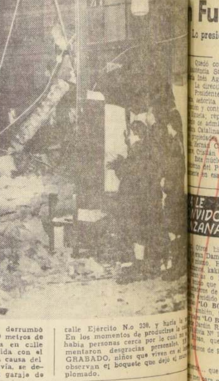
Alrededor de las 22 horas se derrumbó anochecer una muralla lateral de 10 metros de altura en una vivienda ubicada en calle Ejercito N° 320. La mole, reventada con el agua y con sus cimientos flojos a causa del último temporal de viento y lluvia, se derrumbó hacia el interior de un garaje de
