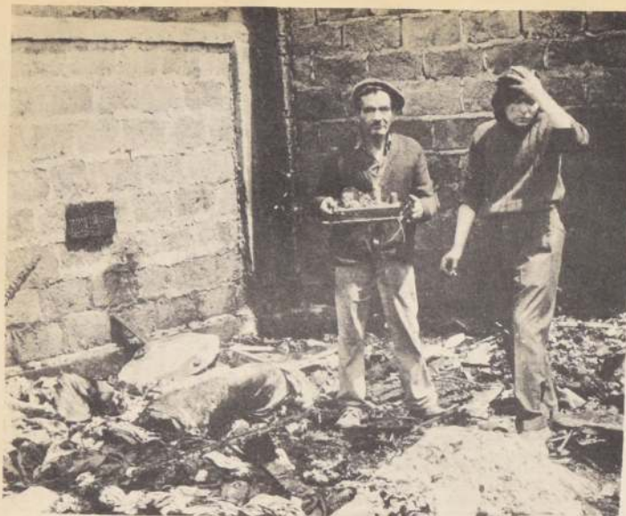
DESGARRADORA TRAGEDIA. Sólo un hacinamiento de humeantes escombros quedó de esa vivienda de la calle "Canal Beagle" número 9869, de la población "Isleto Snipe" de la densa comuna de Cisterna.
