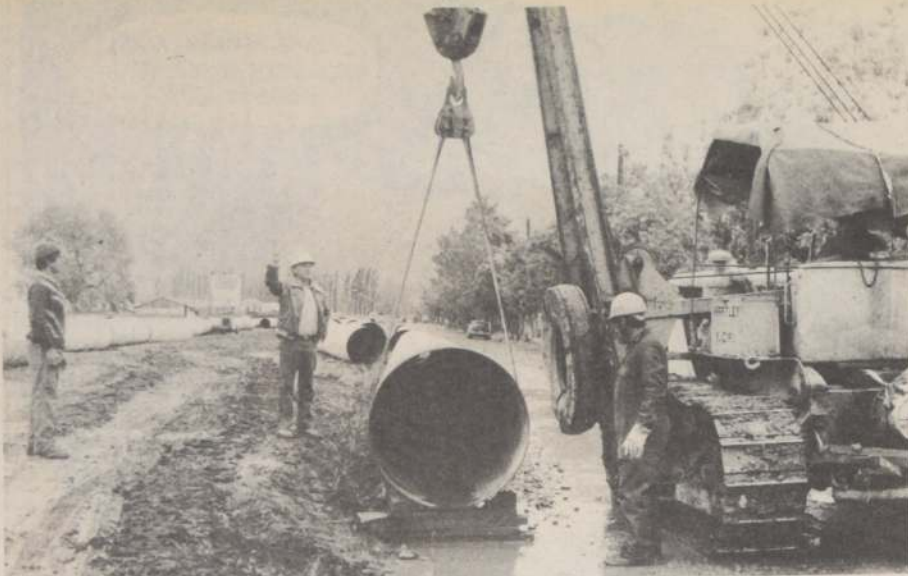
En la foto, una de las tuberías alimentadoras que está construyendo la Empresa Metropolitana de Obras Sanitarias, para mejorar el abastecimiento de agua potable en la región. Estará ubicada en La Florida.
