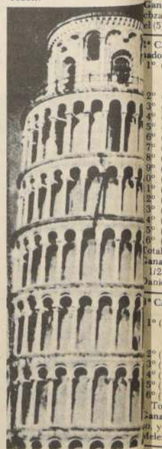
La famosa torre de Pisa, en Italia, ha sido objeto de innumerables ocasiones de inclinación, señalando la inclinación próxima a su total derribo. Pero ahí está. Inclinada, sigue firme.
