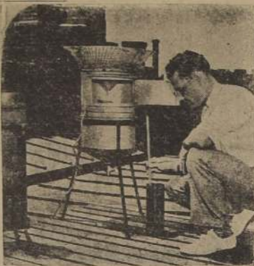
LA MEDIDA DE LA LLUVIA.—La Oficina Meteorológica mide la lluvia que cae en todos los puntos de los Estados Unidos. Aquí aparece el meteorólogo, Mr. Jones, midiendo la precipitación de las últimas 24 horas. Mide hasta las fracciones de un milímetro. El tubo que aparece a la izquierda se emplea para medir la caída de la nieve en los meses del invierno.
