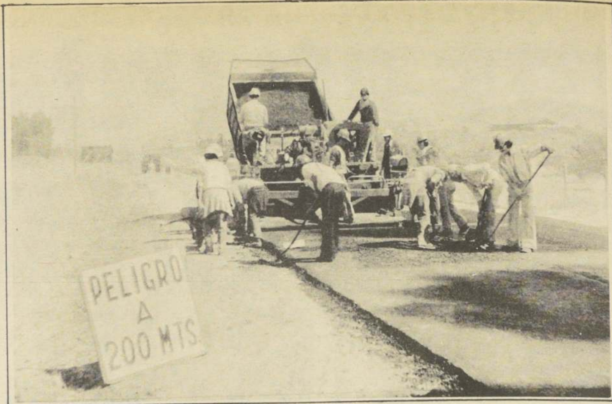
TRABAJOS DE ENRIPIADO en caminos de acceso a poblaciones y escuelas, se realizan en estos momentos, beneficiando a miles de pobladores.
