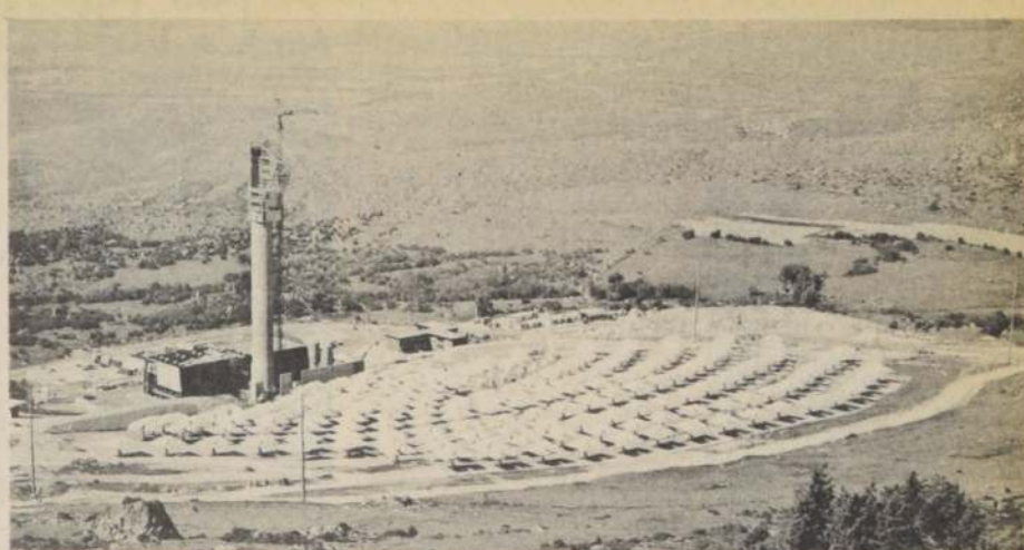
Vista general de la central de Thémis en julio de 1981. La primera central solar francesa se encuentra en Targassonne. Consta de 201 heliostatos que cubren una superficie de 10.793 m². Su torre de hormigón tiene una altura de 80 metros. (Foto PIRDES.)
