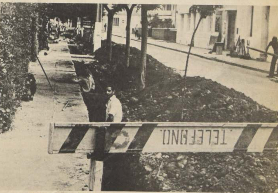
Esta es una de las tantas excavaciones que se realizan en las calles de Rancagua para la instalación de las nuevas líneas telefónicas subterráneas.
