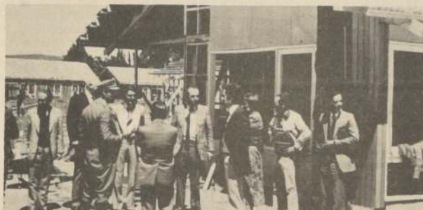
El Gobernador y todos los Alcaldes de la provincia de Malleco visitaron las cuatro casas en proceso de terminación de la Aldea Infantil S.O.S., de Angol, que serán entregadas el 7 de diciembre. La idea, llegada de Austria, ha prendido con entusiasmo en la zona.
