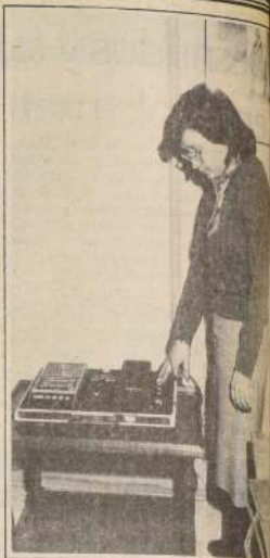
Este simple aparato, denominado Psicoanalizador de voz, es capaz de detectar las inflexiones de las curvas vocales de un individuo, de acuerdo a la carga emotiva que evidencie frente a una pregunta relacionada con el delito que se le imputa como sospechoso.
