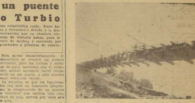
El puente sobre el río Turbio, en el camino de Pucón al interior, se encuentra colapsado debido al exceso de tránsito de vehículos de gran tonelaje, para cuyo objeto no fue construido. En el grabado se puede observar a obreros que hacen reparaciones transitorias que en nada solucionan el serio problema que afecta a miles de agricultores y madereros de la región.
