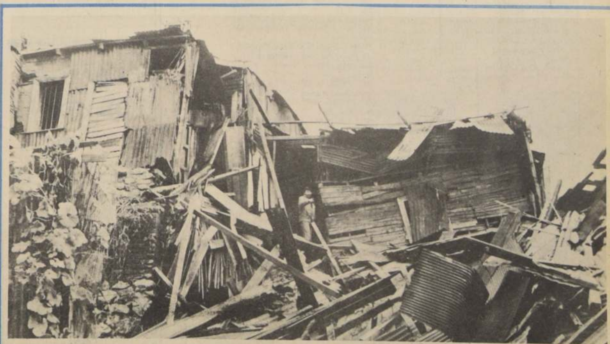
Tres casas se derrumbaron en el sector de las calles Gutenberg y Lecheres, en el Cerro Barón, debido al reblandecimiento del terreno por las lluvias y los sismos; otras dos viviendas siguen en peligro.
