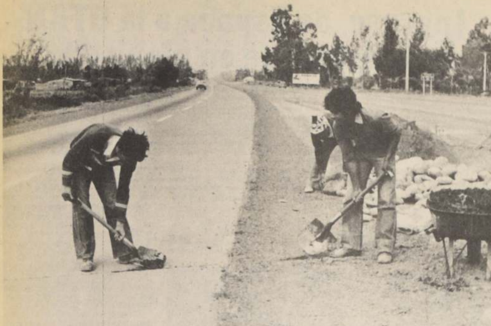
Reparaciones en la carpeta de rodado efectúa personal de Vialidad Regional en la Ruta 78 de Santiago a San Antonio. Los trabajos pretenden dejar en buenas condiciones la vía para enfrentar el intenso tráfico de verano.
